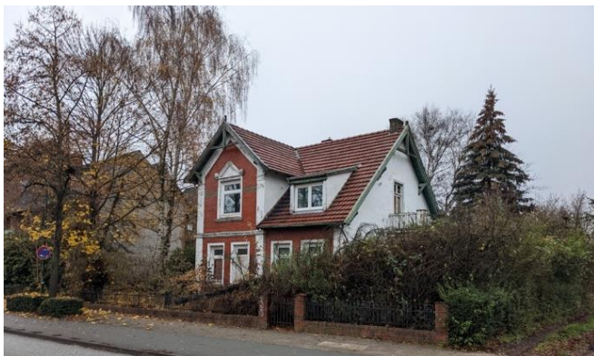
Abbildung 8: Ortsbildprägendes Privatgebäude mit Sanierungsbedarf
